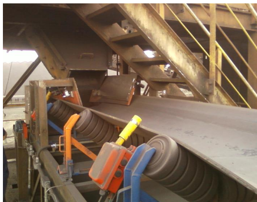
Figura 10. Vista do Chute de Alimentação do Transportador de Correia Reversível. Fonte: Autor
