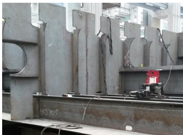
Figura 2- Dois painéis navais, horizontal e vertical unidos por solda em ângulo. Autores (2016)
