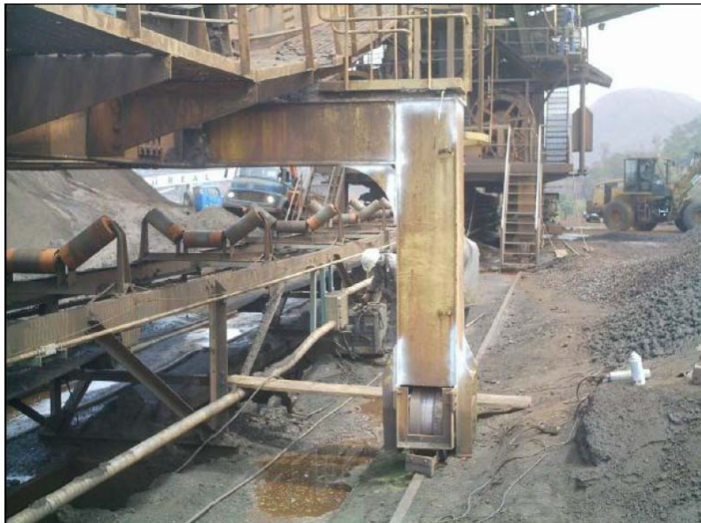
Figura 4. Verificação das soldas no pórtico do tripper.
