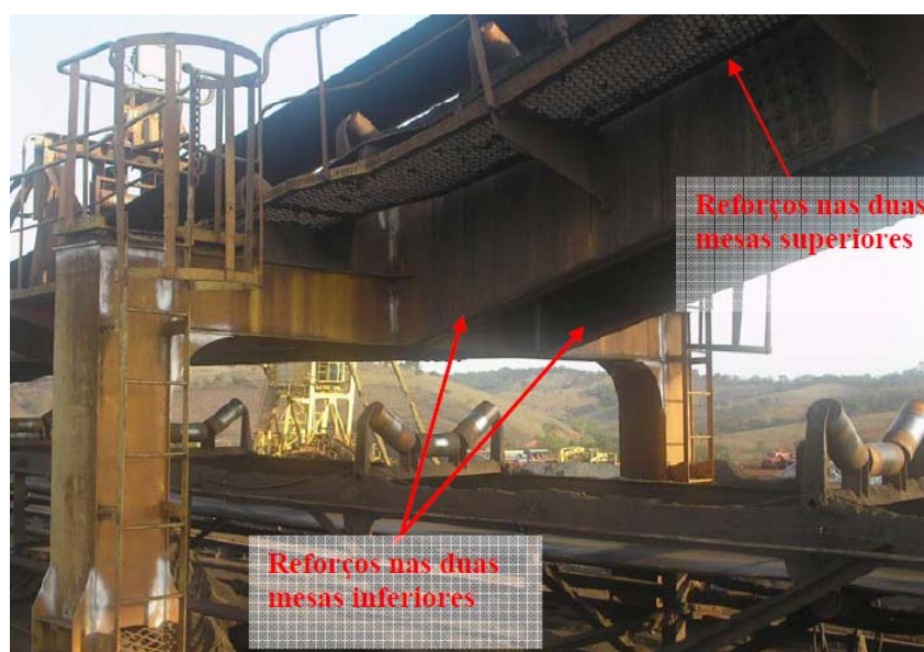
Figura 9. Regiões a serem reforçadas no tripper.
