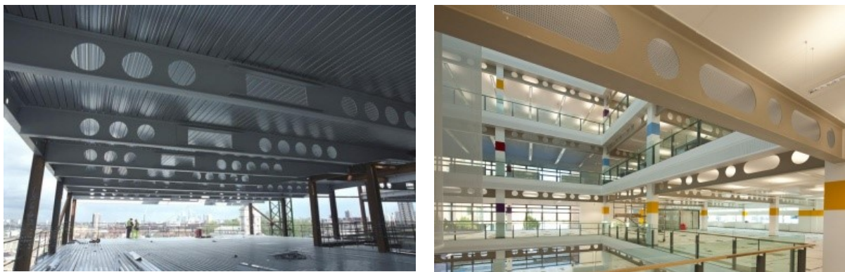
Figura 3 – Vigas com aberturas irregulares na alma.
