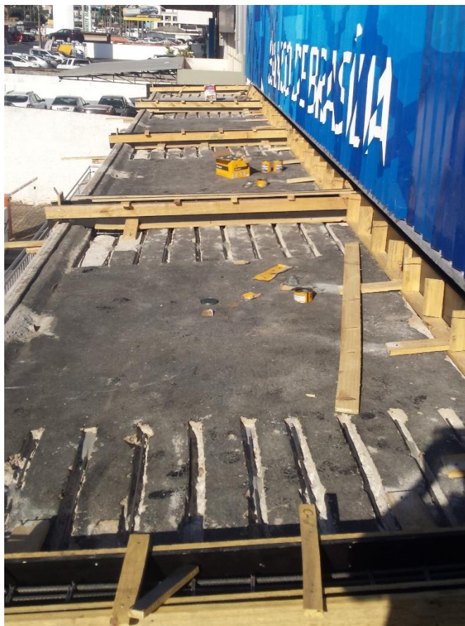
Figura 6. Novas vigas e armadura de solidarização
