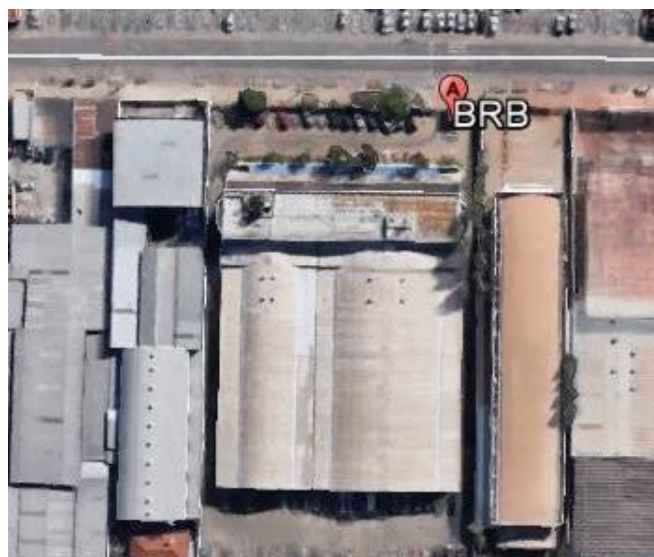
Figura 3. Localização da Edificação
