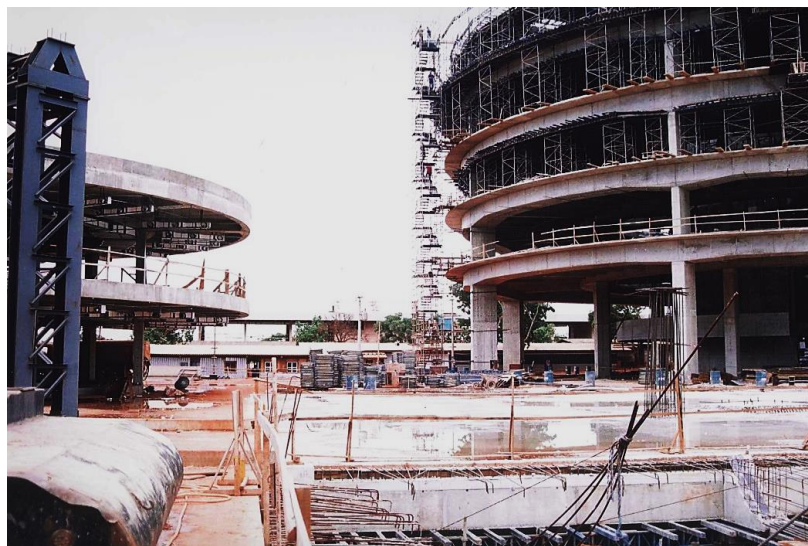
Figura 5. Edificação em fase de construção , bloco B; Fonte: Arquivo da PGR
