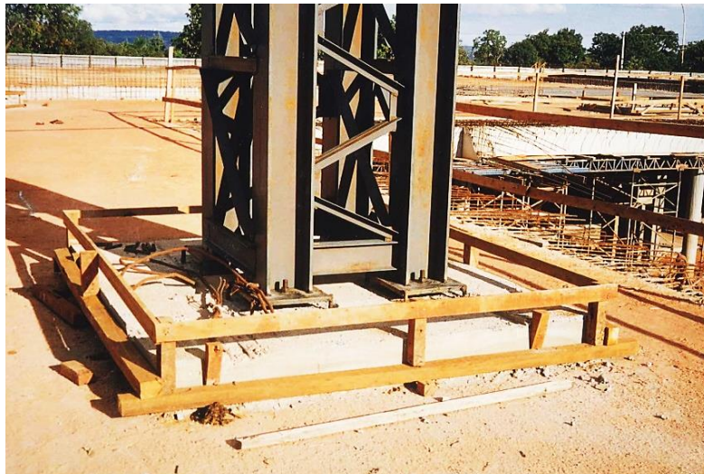
Figura 5. Pilares provisórios, bloco A; Fonte: Arquivo da PGR
