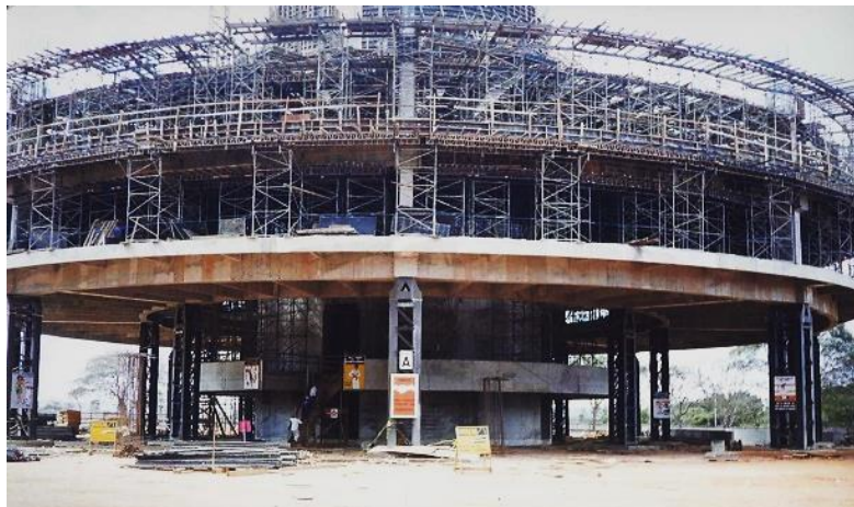
Figura 6. Pilares provisórios no canteiro de obra, bloco A; Fonte: Arquivo da PGR
