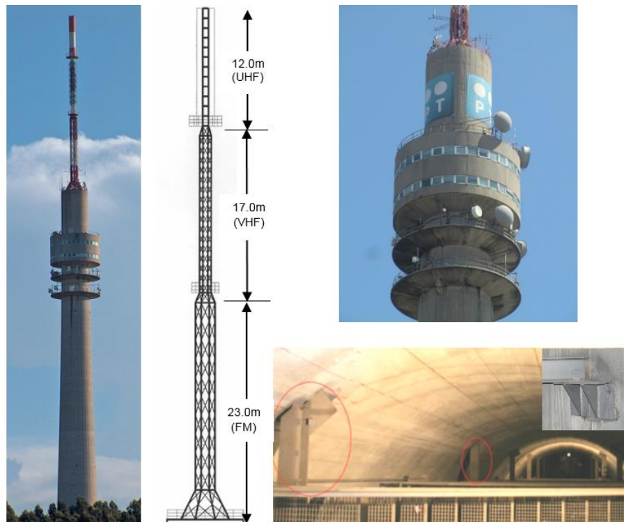
Figura 1. Torre de telecomunicações do Monte da Virgem: a) vista geral; b) torre metálica; c) pisos técnicos; d) vista de topo das vigas de travamento da parede do fuste e pormenor do apoio
