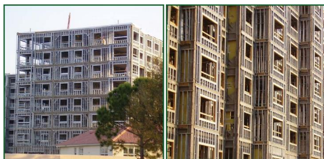
Figura 2: Edificação multi - pavimentos em Light Steel Framing
