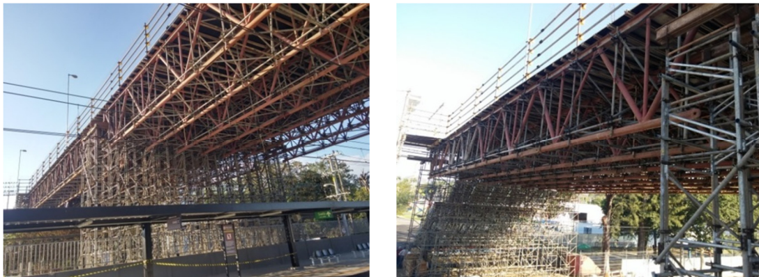
Figura 5. Detalhes das treliças da estrutura da passarela
