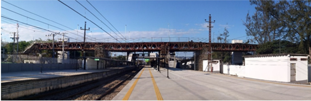
Figura 4. Visão geral da estrutura da passarela
