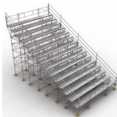
Figura 2. Arquibancada temporária construída com sistemas de cimbramento
