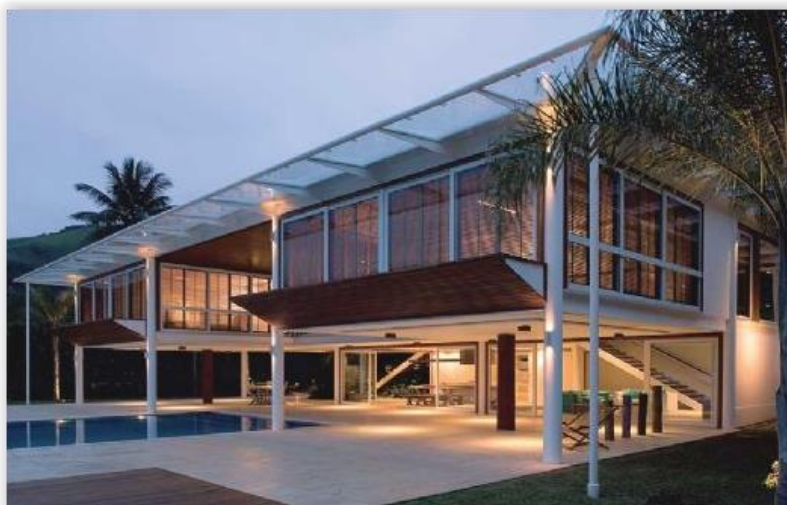
Figura 1. Edificação em aço.
