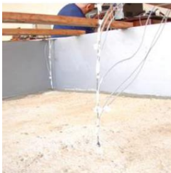
Figura 2. Termômetros instalados no centro da forma
