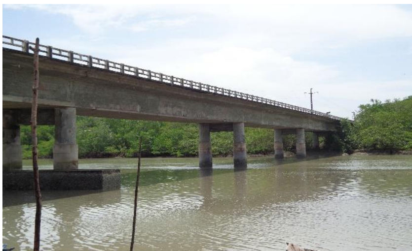
Figura 3: Vista geral da ponte
