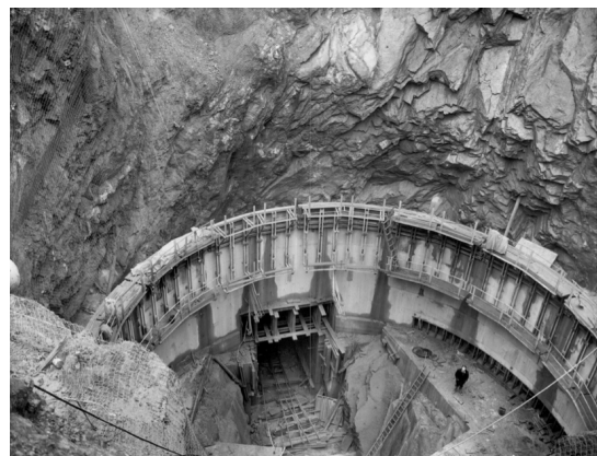
Figura 2: Estrutura cilíndrica usada como parede de contenção de uma mina (Eller, 2009)
