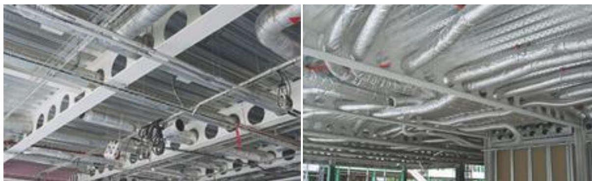
Figura 2. Vigas celulares com dutos de serviço (www.steelconstruction.info, 2016)
