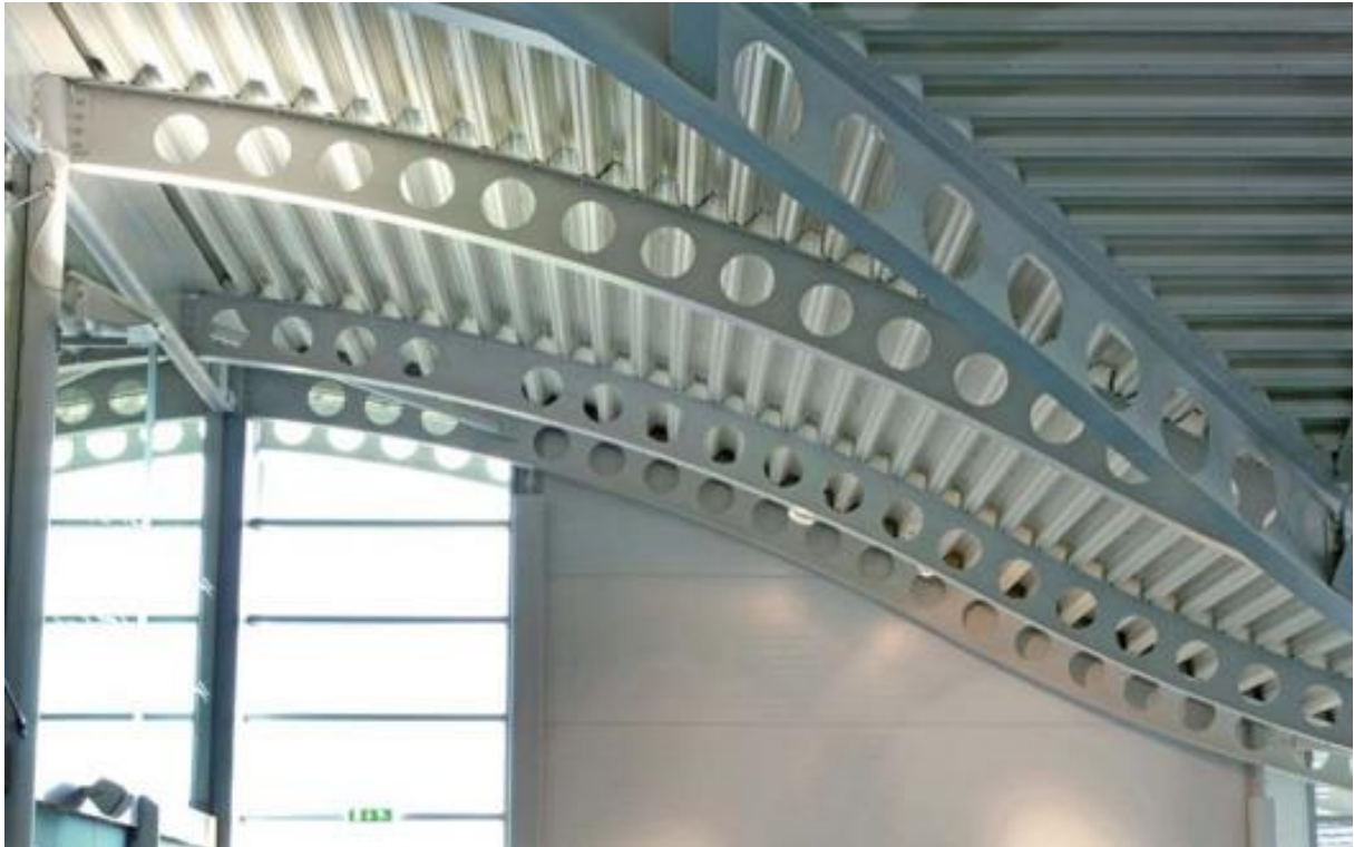
Figura 3. Vigas celulares (www.wrap.org.uk, 2016)
