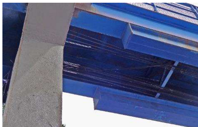
Figura 6. Reforço das longarinas perfis duplo I americano 12"x60,6.
