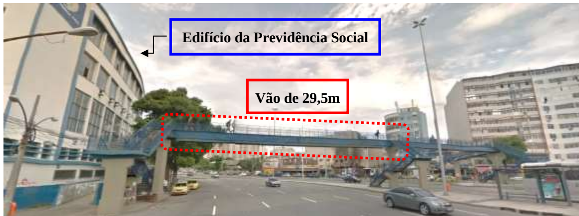
Figura 2. Vista do trecho analisado ao lado do prédio da Previdência Social (à esquerda).
