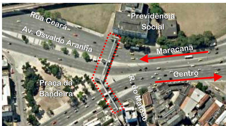
Figura 1. Situação da passarela (Imagem de satélite).
