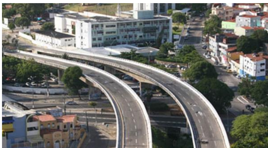
Figura 1. Viaduto do Baldo, Natal-RN.
