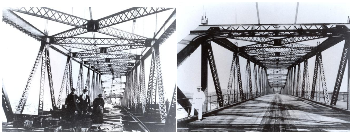
(a) Montagem dos elementos metálicos de suporte. (b) Tabuleiro do vão central concluído.
