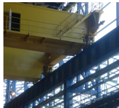
(c) Viga de rolamento suportando ponte rolante
