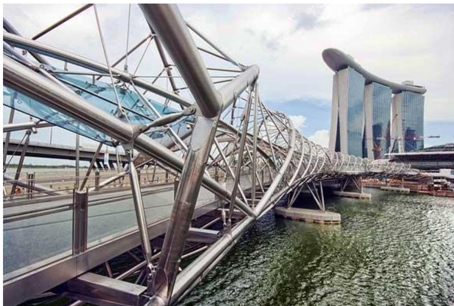
Figura 1. Ponte Helix em Cingapura, composta por perfis tubulares (Portal Metálica, 2017)
