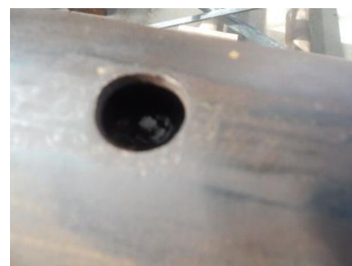
(c) Furos com diâmetros de 6 mm para o alcance da superfície dos tubos internos.
