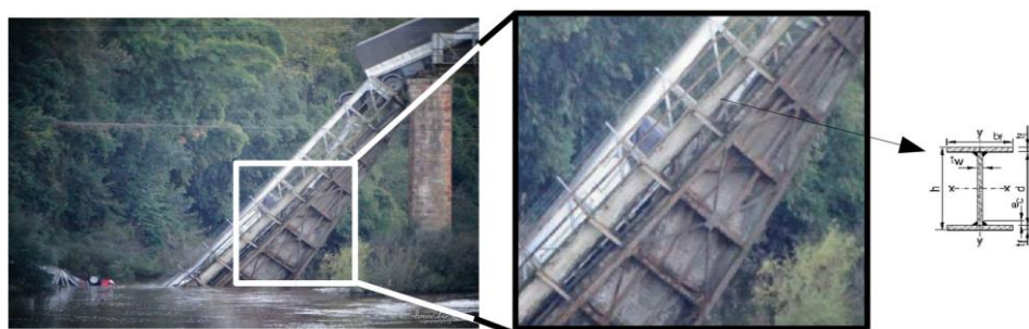
Figura 1 - Detalhe das vigas principais da estrutura
