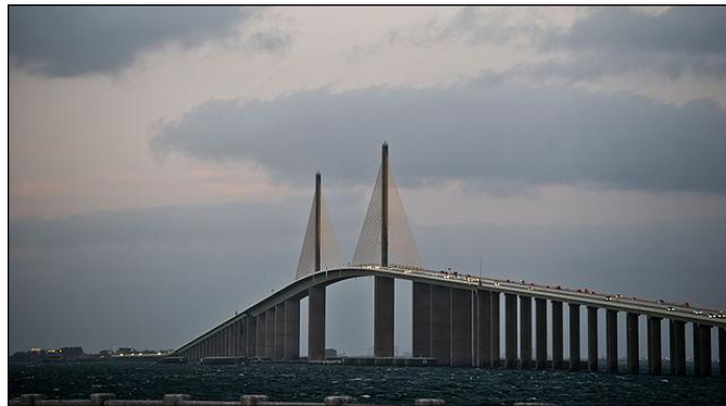
Figura 1. Vista da ponte estaiada Sunshine Skyway
