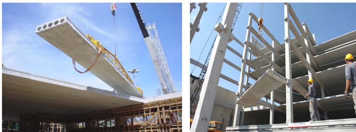
Figura 1. Posicionamento da laje alveolar. (Fonte: < http://www2.cassol.ind.br >. Acesso em: 27 de ago. 2012).
