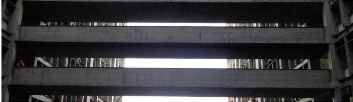
Figura 1. Passarela investigada: vista lateral
