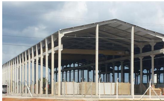
Figura 2. Galpão em estrutura de concreto pré-fabricado
