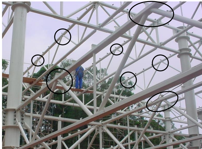
Figura 2: Ligação do tipo “K” com afastamento (fonte: Vallourec)
