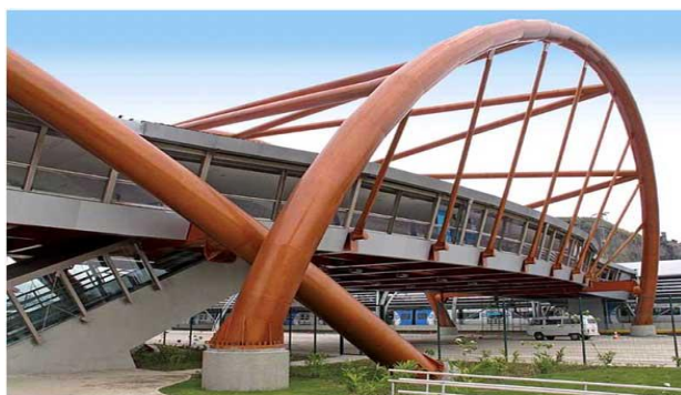
a) Passarela, Rio de Janeiro
