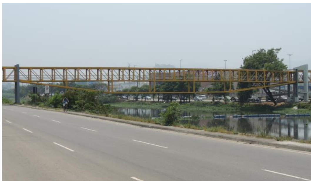
Figura 2. Vista lateral global da passarela
