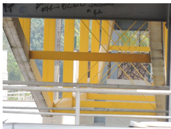
b) Detalhe do reforço estrutural
