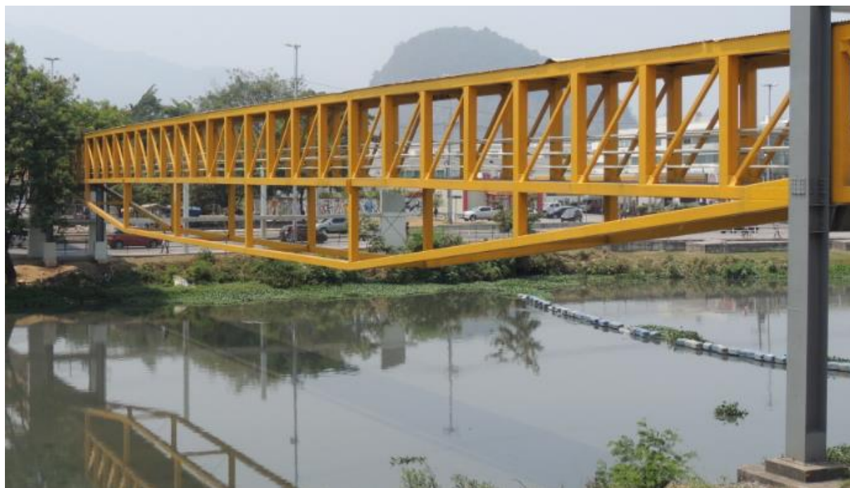
Figura 3. Vista lateral próxima a região dos apoios do vão central
