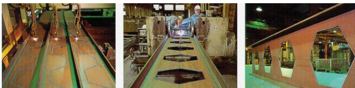
Figura 1. Fabricação de vigas casteladas (Gemperle, 2007).
