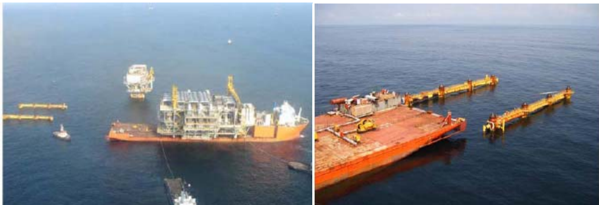
Figura 3. Embarcação no momento da instalação fora da Jaqueta (OTC 19073, 2007)
