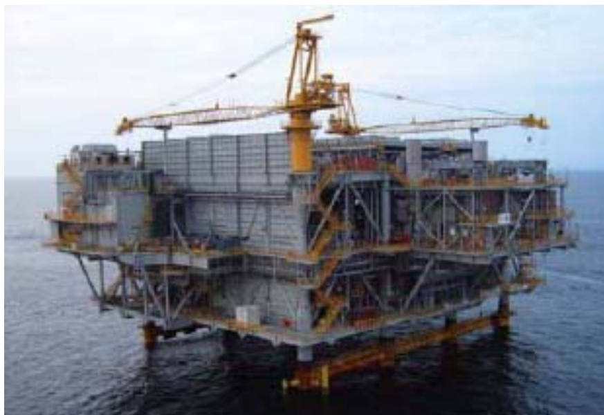
Figura 4. Topside instalado após a retirada da embarcação (OTC 19073, 2007)
