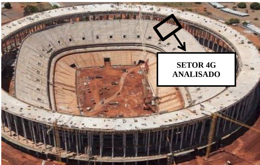
Figura 7. Detalhe do setor da arquibancada analisado neste trabalho (Lima, 2013)
