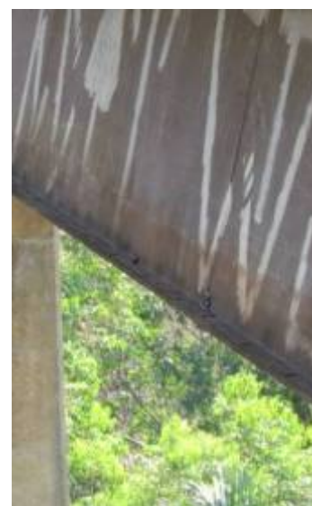
Figura 25 – Foto de emenda na lateral
