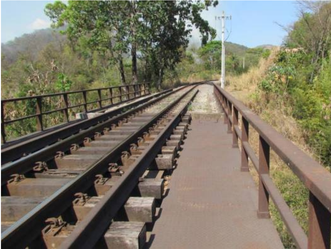
Figura 9 - Vista da ponte com destaque para o trilho, contratrilho, dormente e guarda corpos
