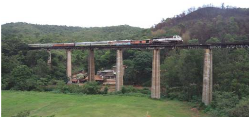
Figura 1 - Ponte sobre o Ribeirão Taioba
