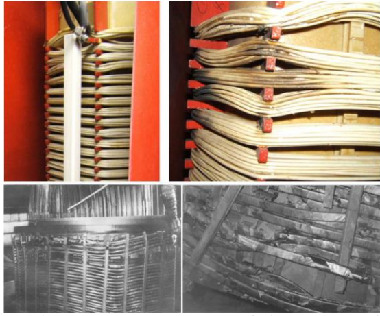
Fig. 4. Deformações em enrolamentos devido às forças eletromagnéticas axiais. Fonte: [16].
