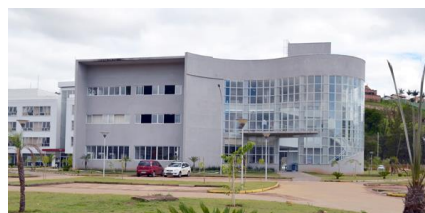
Fig.1 – Prédio do Campus em Estudo com geração fotovoltaica
