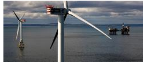
Fig. 2. Foto do parque eólico Beatrice Wind Power na Escócia (Fonte: [21]).
