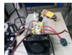
Fig. 5. Detalhe da ponte retificadora e do capacitor eletrolítico utilizado na carga.
