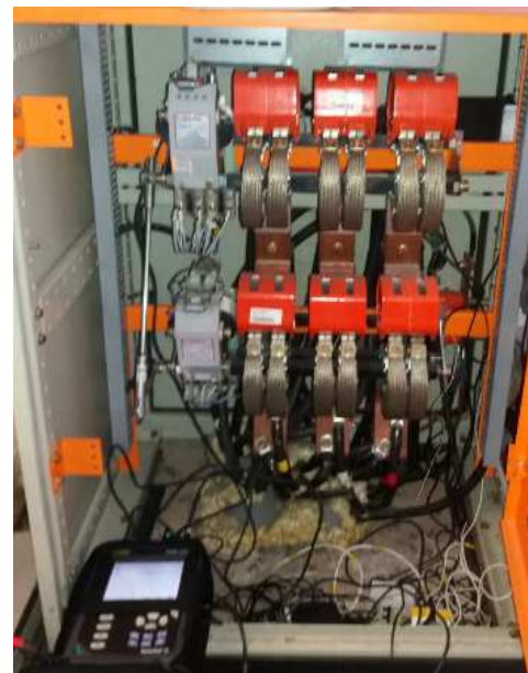
Figura 2 – AEMC 8336 ligado ao quadro de transferência
