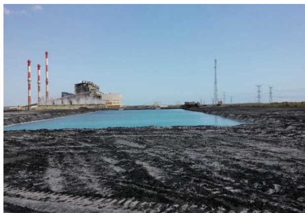
Figura 1 – Módulo I de armazenagem.
