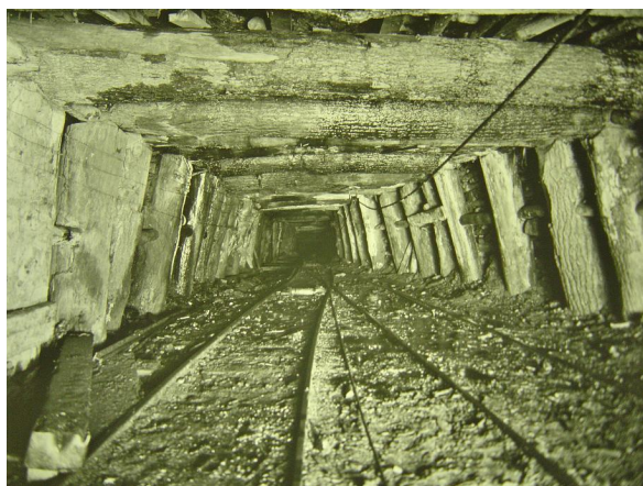
Figura 2 - Escoramento em minas de carvão, utilizando madeiramento ( square-set timbering )
