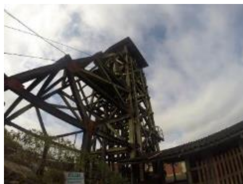
Figura 11 - Torre da gaiola da UM II – Verdinho.
