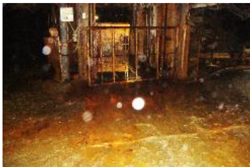
Figura 12 - Gaiola do poço de acesso.
