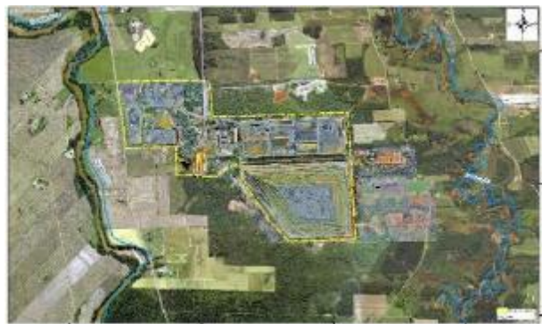
Figura 2 – Pátio operacional da UM II – Verdinho.
