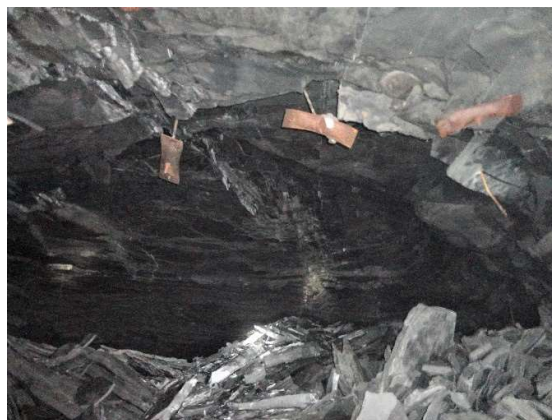
Figura 1 - fotos do teto com juntas verticais e blocos.
