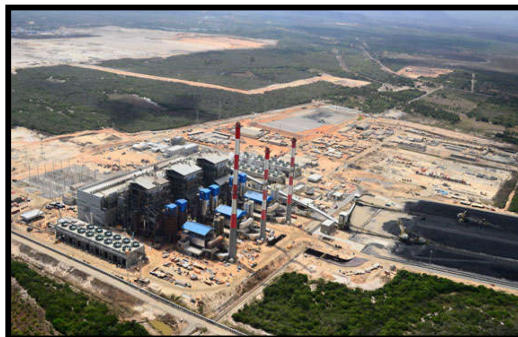
Figura 1 - Vista aérea da UTE Energia Pecém.
