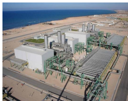
Figura 3. Estação de compressão de gás – ECOMP
