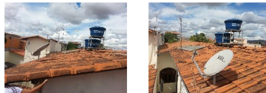
Figura 2. Telhado da residência em estudo.
