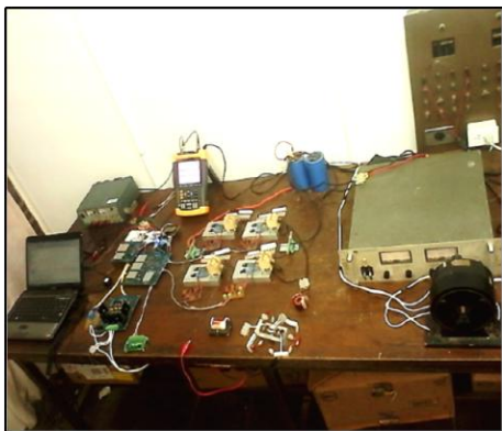
Figura 17. Bloque de pruebas implementado para la interconexión a la red eléctrica.
