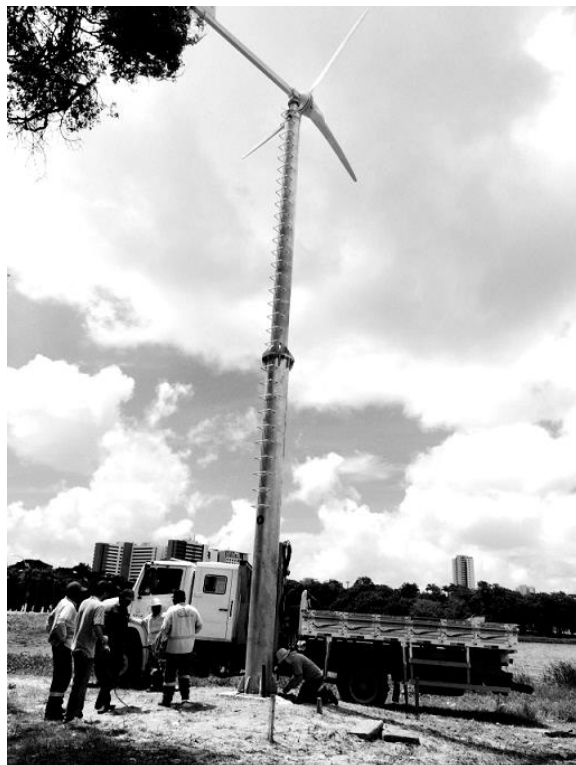
Figura 3. Instalação do aerogerador VERNE555.
