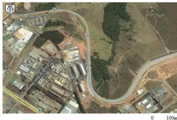
Figura 1. Via de acesso ao pátio de manobra da ferrovia Norte-Sul.
