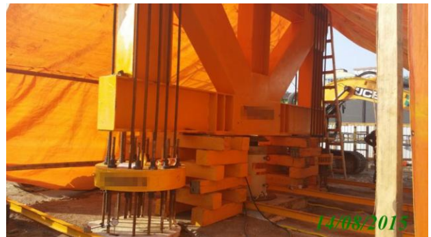
Figura 8. Vista do sistema de reação.
