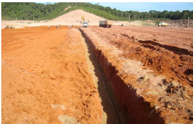
Figura 8. Posicionamento da fibra no filtro vertical, face de jusante.
