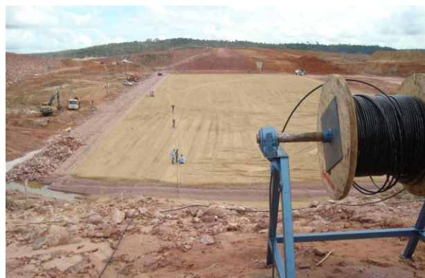
Figura 6. Local de posicionamento da fibra no tapete drenante horizontal entre estacas 29+20m e 35.
