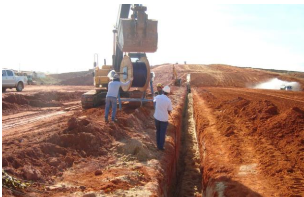
Figura 7. Instalação da fibra no filtro vertical.
