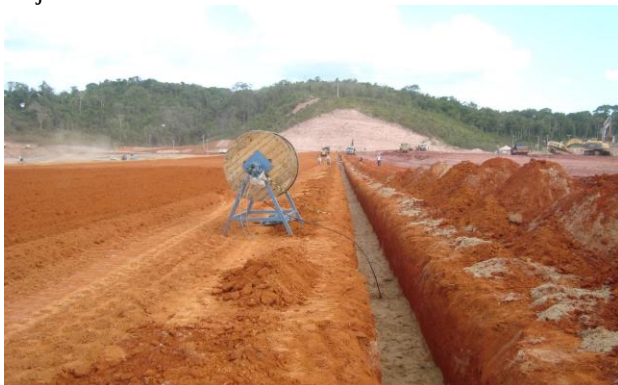
Figura 9. Fibra instalada no filtro vertical aguardando fechamento de filtro com material 2B e continuidade de núcleo.
